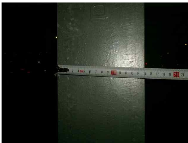
주골조 부재치수 현장측정
