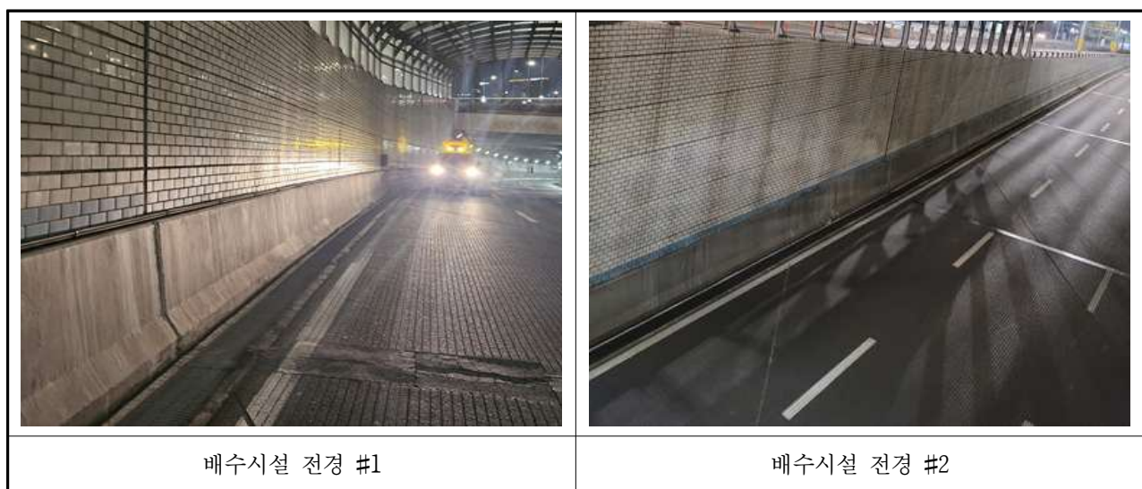
【사진 3.4.11】 배수시설 전경
