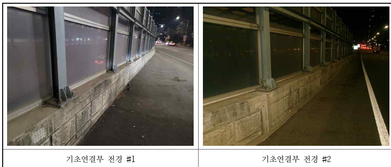
【사진 3.4.5】 기초연결부 전경
