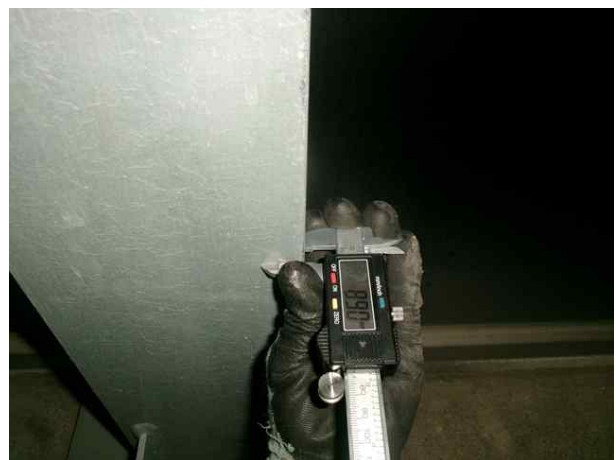
주골조 부재치수 현장측정
