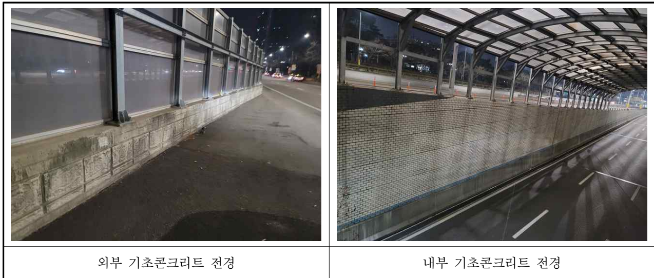
【사진 3.4.7】 기초콘크리트 전경
