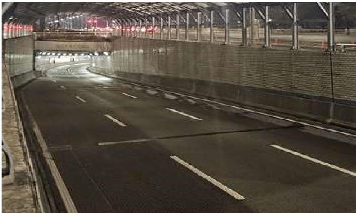
내부 도로포장 전경
